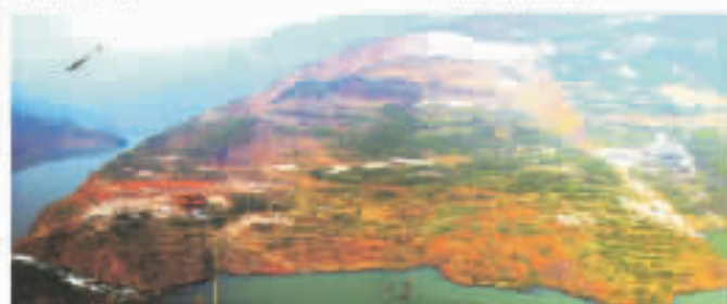
图13 2003年7月失稳的千将坪滑坡 Fig. 13 Landscape of Qianjiaping landslide in July, 2003
