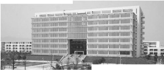
图 6 拼接后的建筑物全景图
