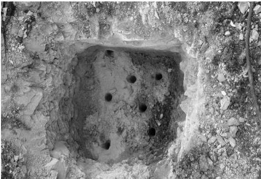
图 5 基盘坑底钻设吸湿根孔
