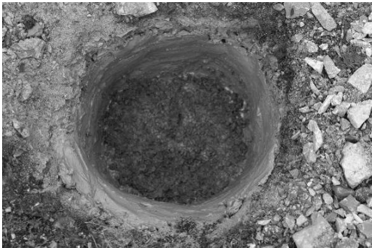
图 6 基坑粘土护壁
