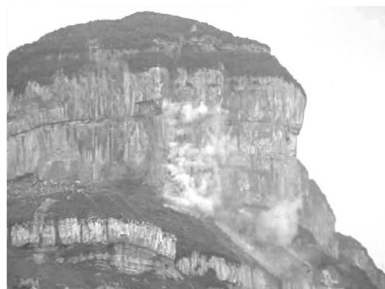
图4 甄子岩 W12# 危岩下座过程中与母岩摩擦成雾
