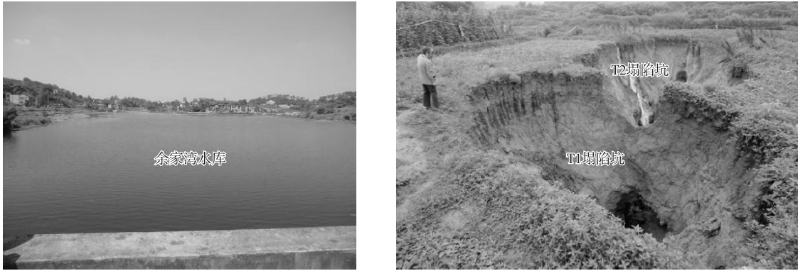
图 1 余家湾水库地面塌陷灾害
