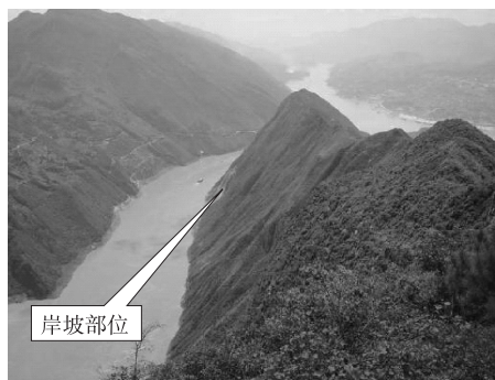
图1 巫峡龚家方岸坡位置
